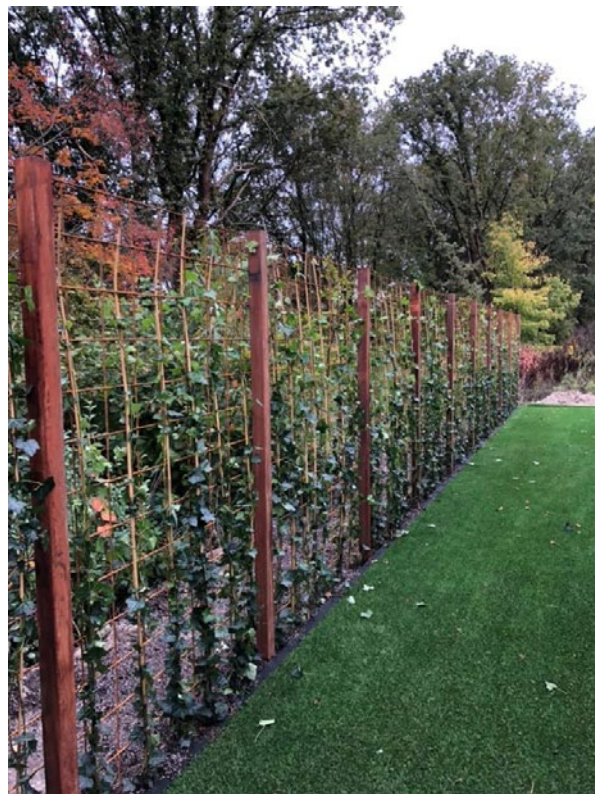
hekwerk van betongaas met klimmers
